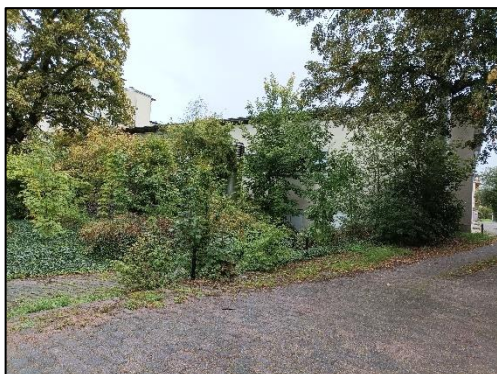
Abb.9: Rückwärtige Ansicht Einfahrt OP
