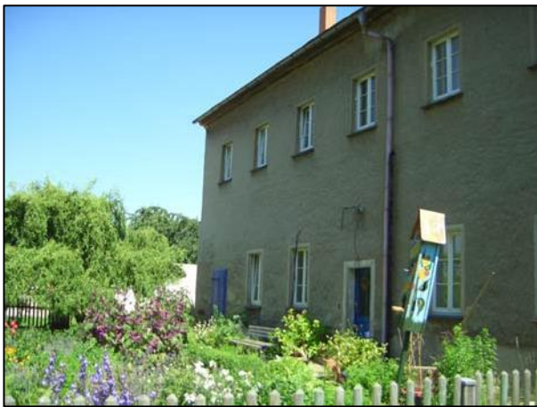
Abb.15: Wohnhaus westlich des Plangebietes
