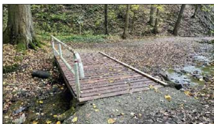
Die neue Brücke auf dem Zschopautalweg
