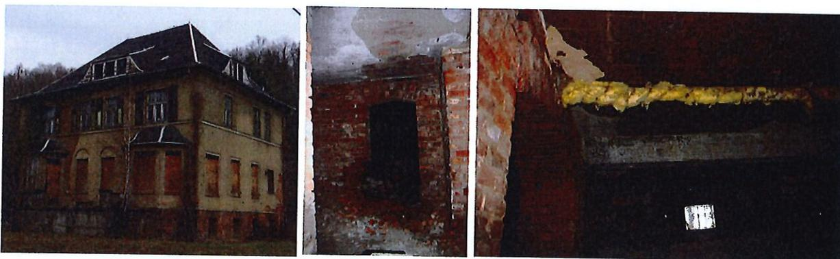
Die Geschossdecke zwischen Keller und Erdgeschoss ist als frühe Ziegeleinhangdecke stahlgelagert ausgeführt, die aufstrebenden Geschossebenen als Holzbalkendecken in traditioneller Form.
