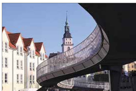
Geh- und Radwegbrücke vor Kirchturm
