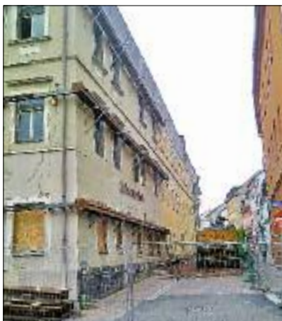
Vorbereitung der Sicherungsmaßnahme Fassade Freiburger Straße
