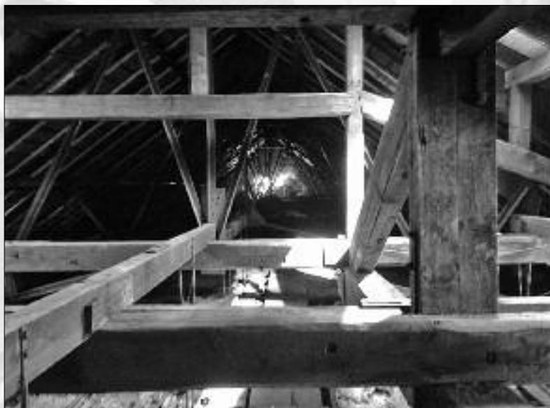
Saniertes Dachhängewerk über dem Welt-Theater-Bühnenhaus
