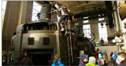
Mit 8 MW Leistung bei einer Fallhöhe von 23 Meter und einer maximalen Durchflussmenge von 36.000 Litern/sec produziert das Kraftwerk durchschnittlich 25 Millionen KWh/Jahr saubere Energie für jährlich rund 9000 Haushalte in der Region. Besonders interessant war aber das mittlerweile außer Betrieb befindliche denkmalgeschützte alte Kraftwerk, in dessen Anlagen die Kids förmlich hineinkriechen
