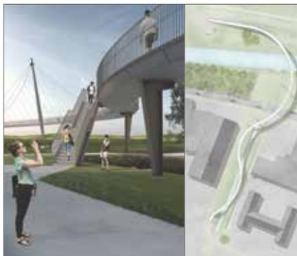
Zur Anbindung der Rad- und Gehwegbrücke an die B 169 ist eine Treppenanlage vorgesehen. Die Brücke wird aus Richtung Dammplatz behindertengerecht ausgebaut und hat eine maximale Steigung von 5 Prozent. Desweiteren wird in den Handlauf eine LED-Beleuchtung integriert. Außerdem kann die Brücke in der Nacht farbig angestrahlt werden.
