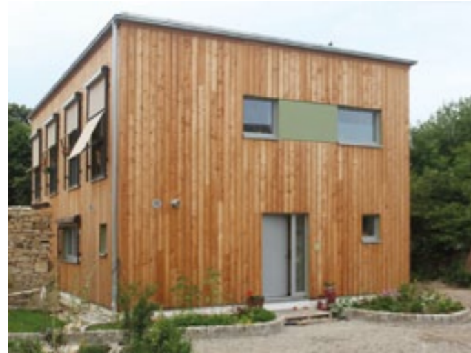
Abb. 3.3.3 Die Außenfassade besteht aus Lärchenholzverschalung.
