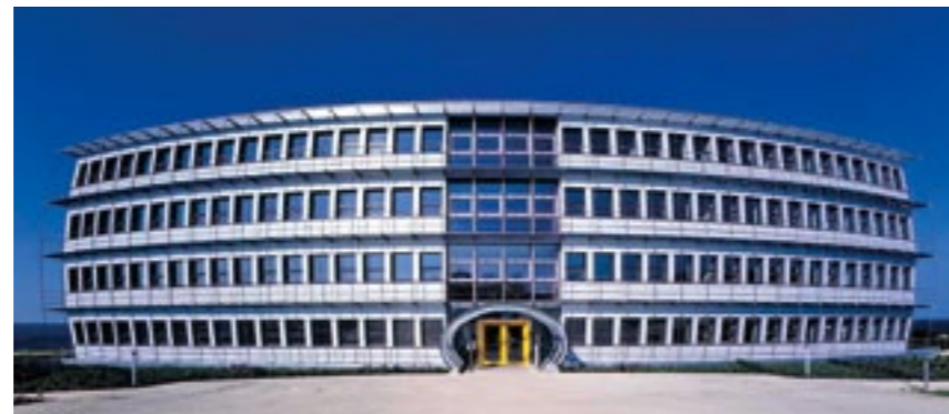
Abb. 2.2.2 Bürogebäude „Energon“ in Ulm: 5 Geschoss, 5412 m 2 , 8.610 m 2 , A/HNF = 1,6
