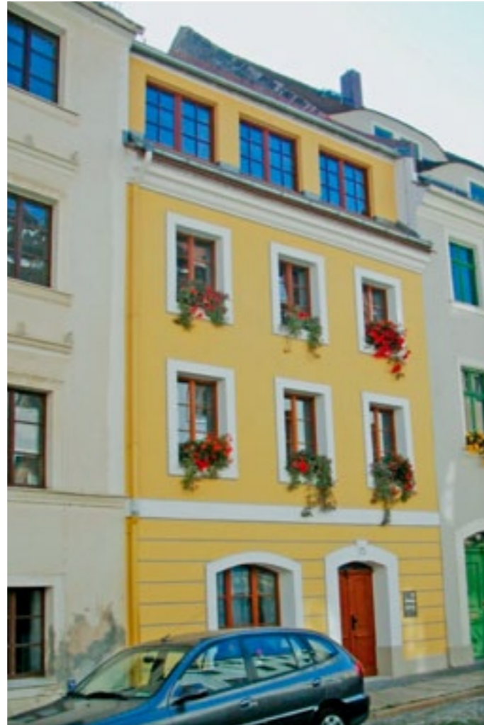
Abb. 3.4.4 Hinter der barocken Fassade verbirgt sich moderne Passivhaus-Technik.
