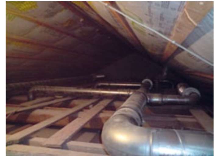
Abb. 3.4.6 Blick unter das Dach – Verlegung der Lüftungsanlage
