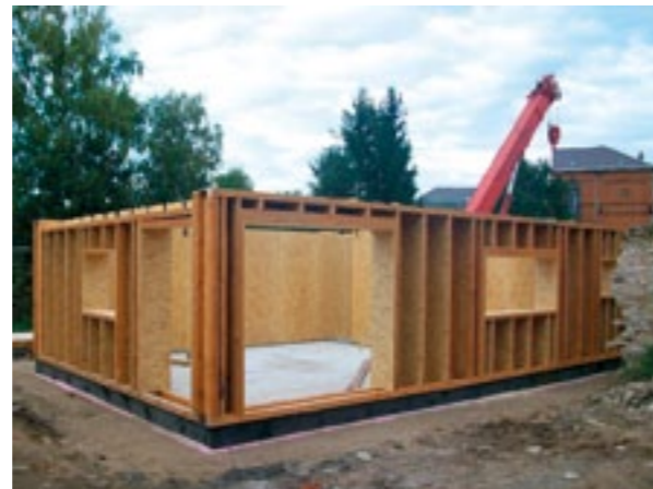
Abb. 3.3.4 Die Holzständerkonstruktion während der Bauphase.
