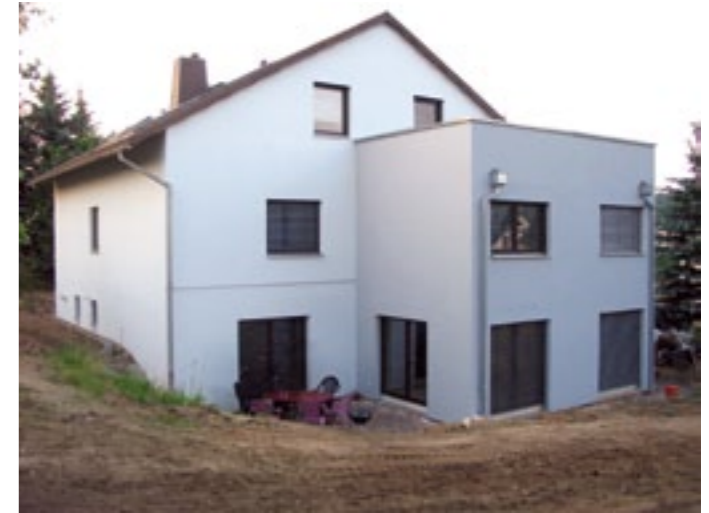
Abb. 3.4.5 Das sanierte Wohnhaus mit Anbau.
