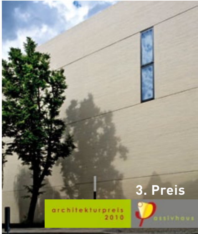
Abb. 3.2.2 Die Fensterflächen des Magazins bestehen aus 3-Scheiben-Isolierverglasung.
